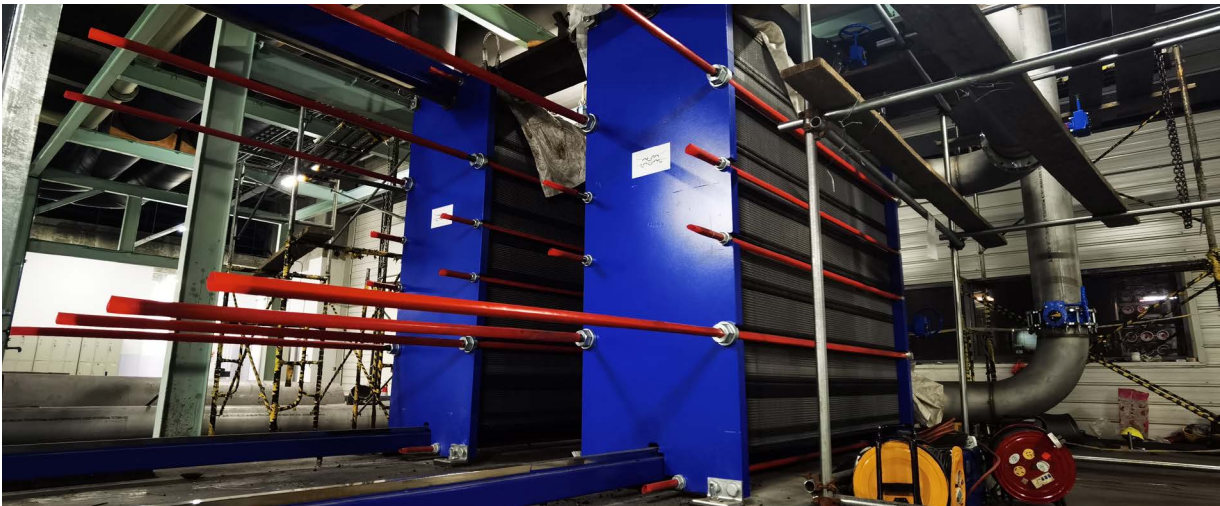
京东方合肥第 10.5 代 TFT-LCD 生产线自来水预热改造项目
