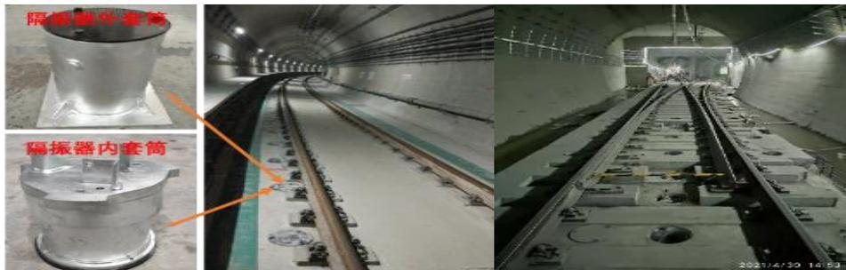
尼)的轨道减振降噪工程。按照适用速度可分为应用于地铁、轻轨(车速不超过 100km/h)的中低速制式浮置板隔振器和应用于市域(郊)铁路(最高车速 100-200km/h)的高速制式浮置板隔振器。
