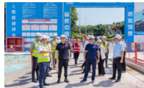
下属公司领导前往项目现场开展安全生产巡检
