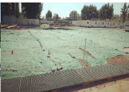
▲施工场所铺设防尘网
