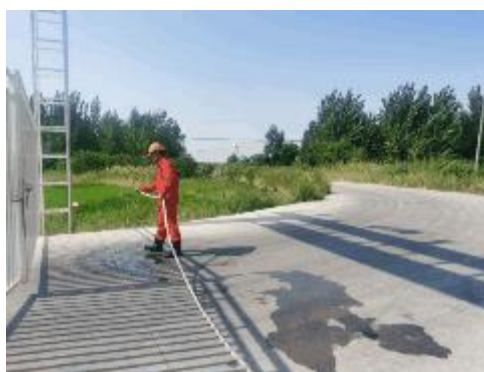
▲井场洒水降尘
