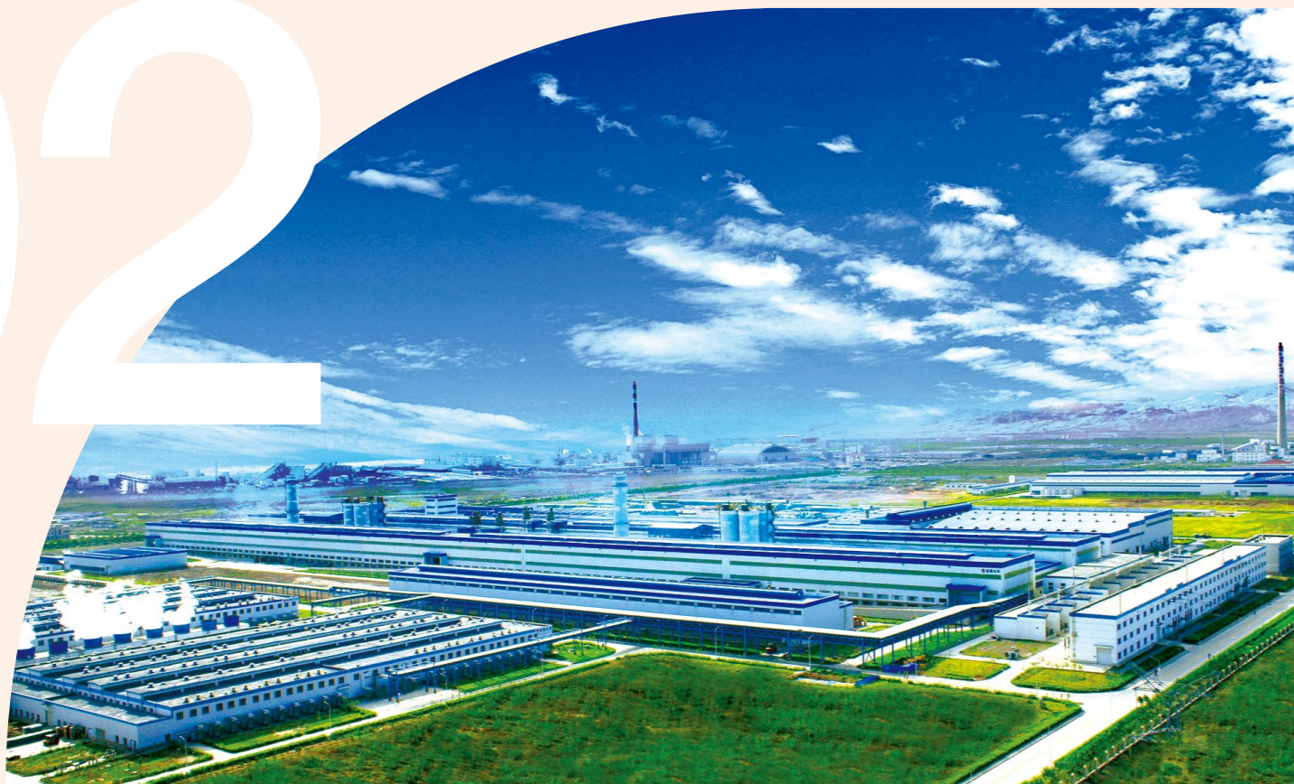
乌鲁木齐甘泉堡国家高新技术产业开发区新材料产业园
