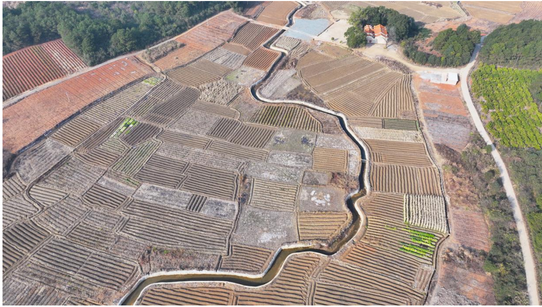
灌溉水渠——“铁建重工渠”
