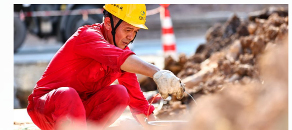
臭气治理项目建设施工
