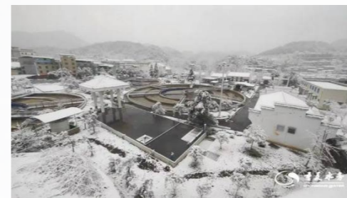
水厂被冰雪覆盖
