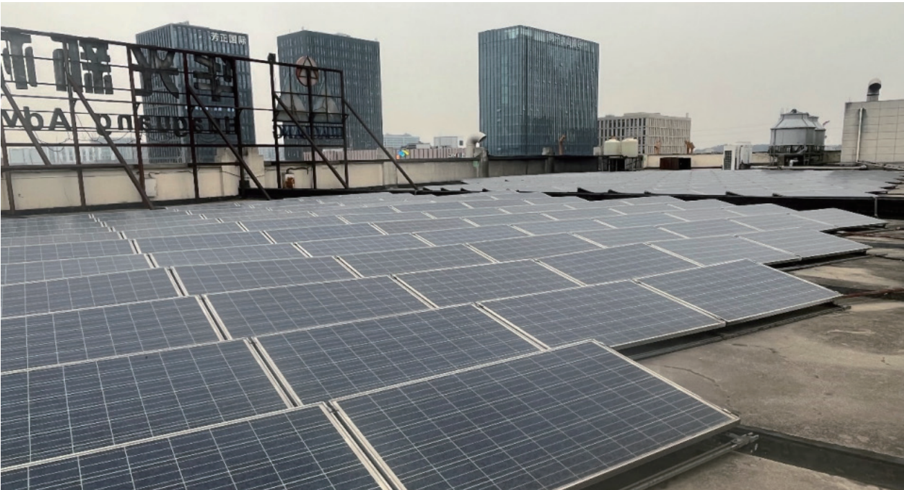
华光新材安装光伏电站
