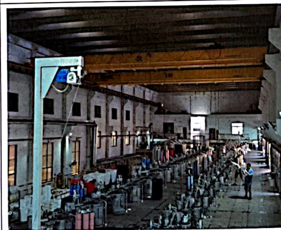
厂房内部照片
