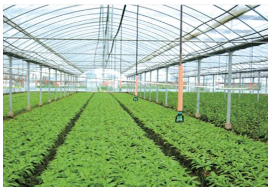
北京平谷温室大棚项目微喷工程
